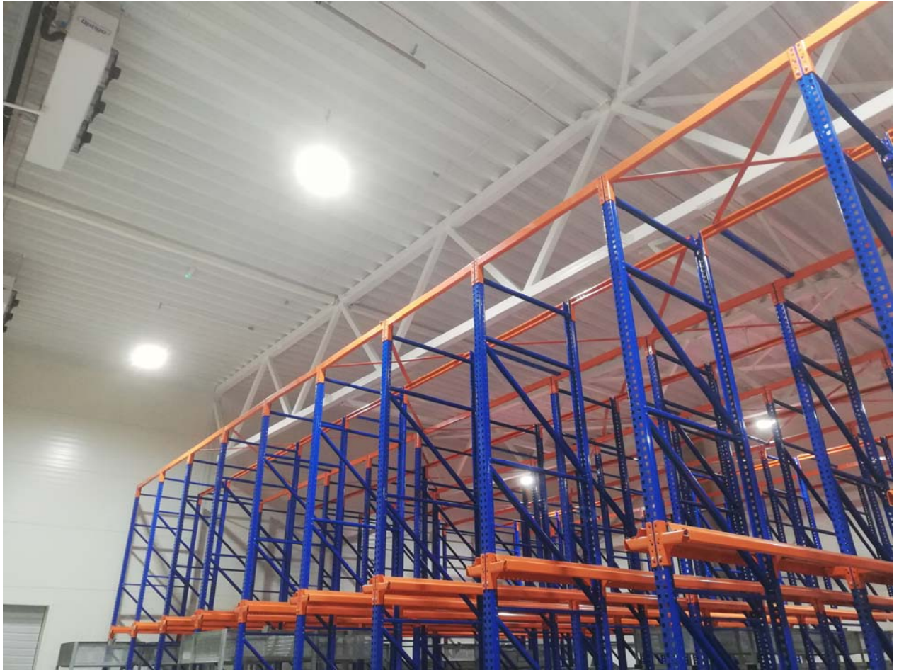
09 pav. Nagrinėjamo statinio 7F1/g stogo konstrukcijų fotografacija
