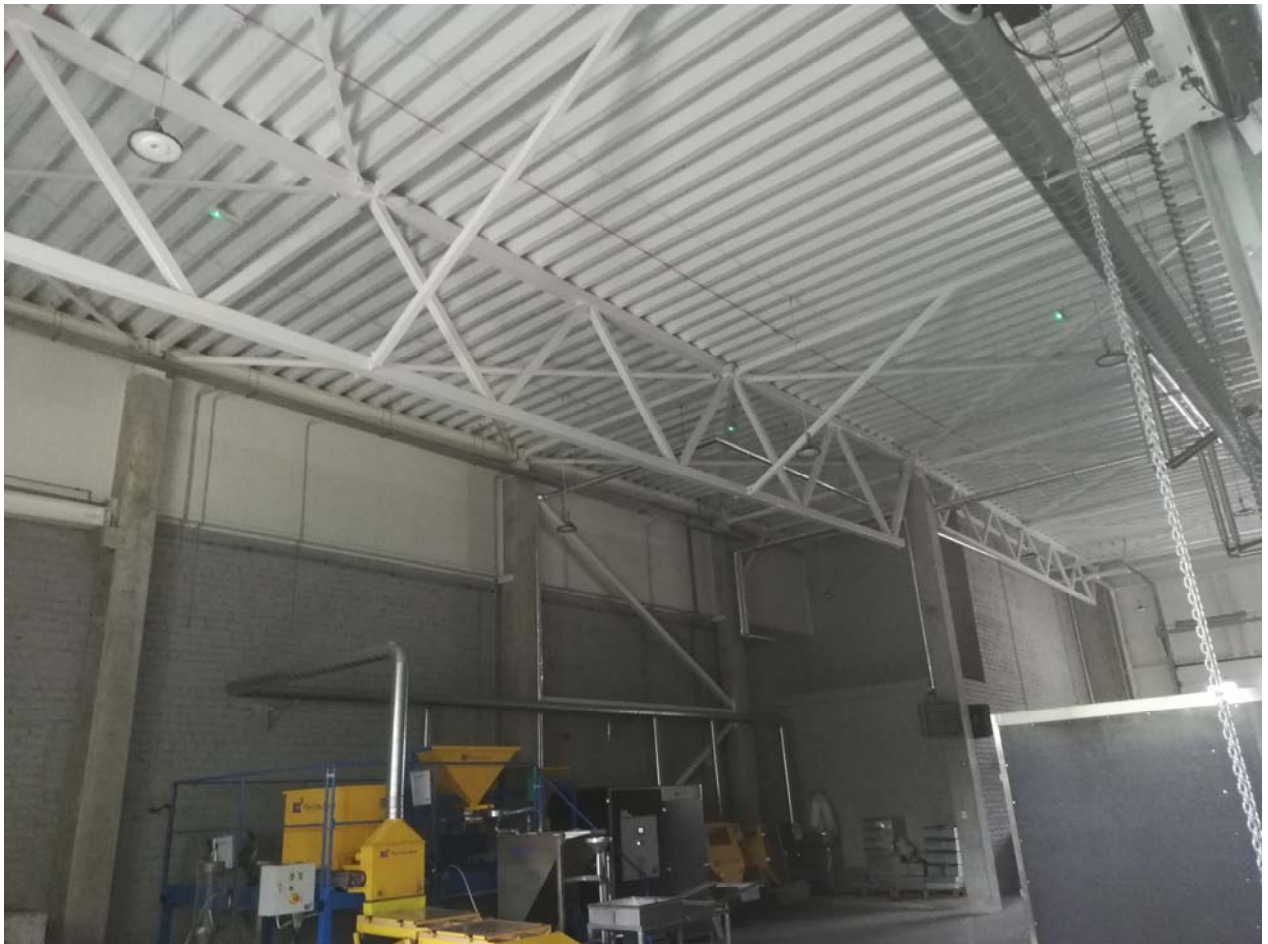
08 pav. Nagrinėjamo statinio 7F1/g stogo konstrukcijų fotografacija
