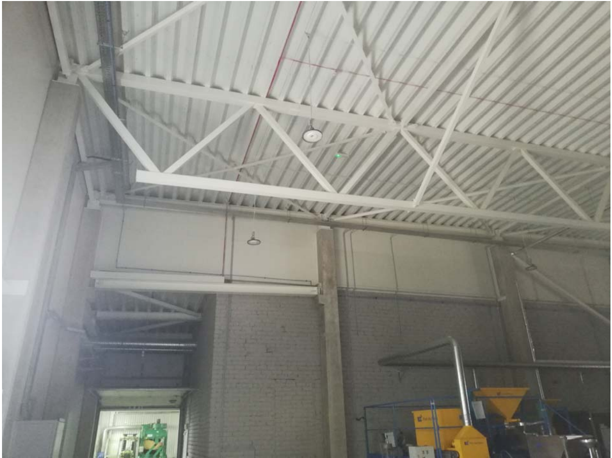
07 pav. Nagrinėjamo statinio 7F1/g stogo konstrukcijų fotografacija
